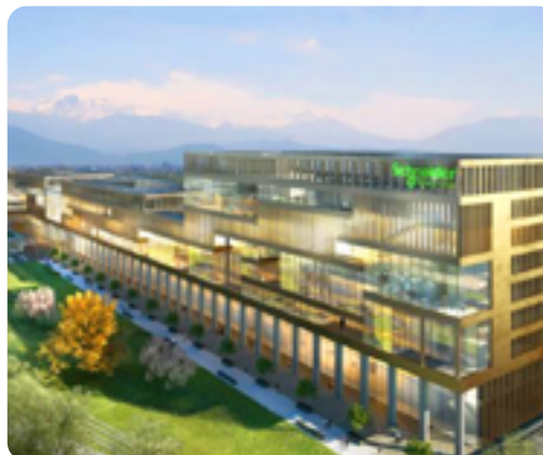
Le projet X-Pole porté par Schneider Electric, à Grenoble
