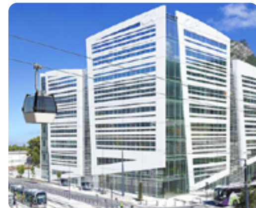
Le futur siège du Crédit agricole Sud Rhône Alpes, à Grenoble
